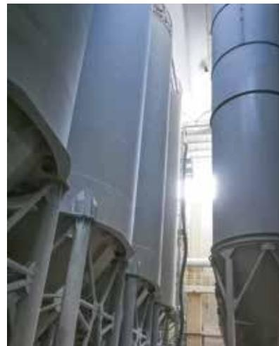
**La polvere di quarzo molto fine immagazzinata in 36 serbatoi cilindrici che hanno un cono inferiore**
