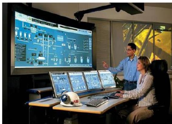
Uno dei punti cardine nel modello da adottare per garantire omogeneità sia nella qualità che nella continuità di erogazione del servizio stà nell'adozione di un sistema di telecontrollo con acquisizione, raccolta e storicizzazione dei dati (SCADA ed Historian) per un corretto monitoraggio di tutti i punti di rilievo nella rete di distribuzione dell'acquedotto.
